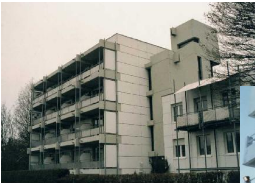
Caritas St. Pius Wohnheim nach Sanierung
